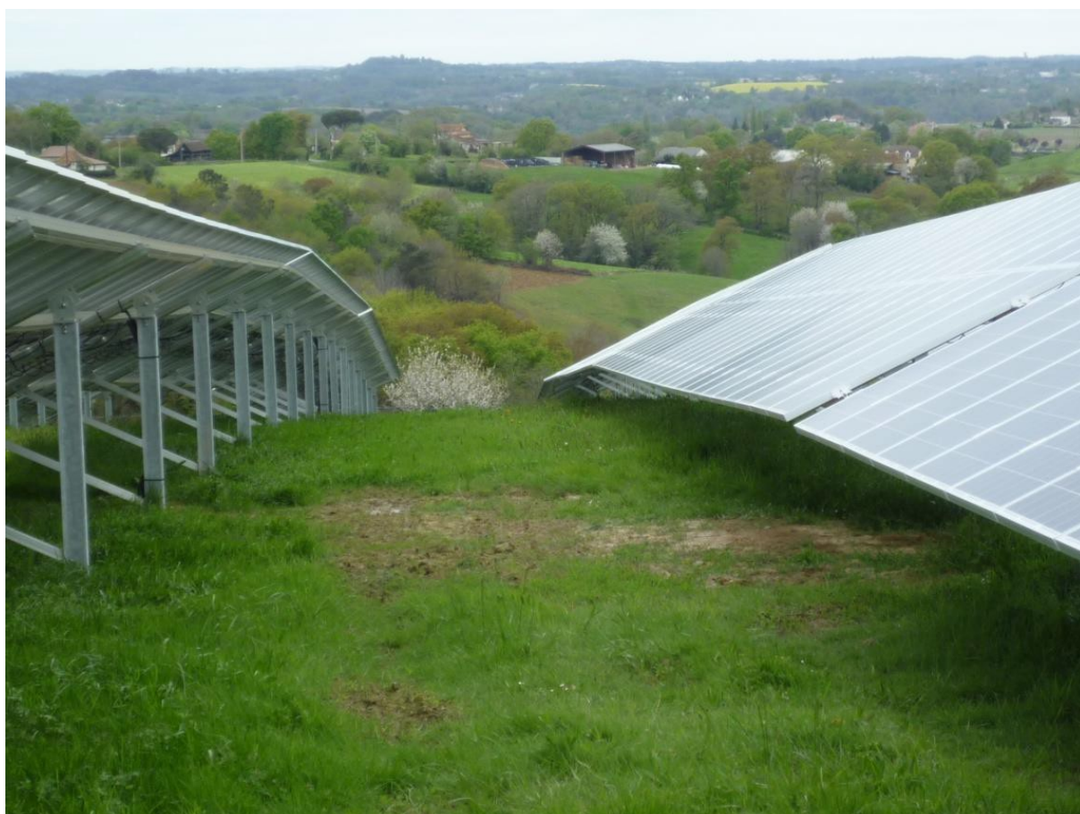
Exemple d'installation de tables de modules photovoltaïques sur pieux battus dans le sol
